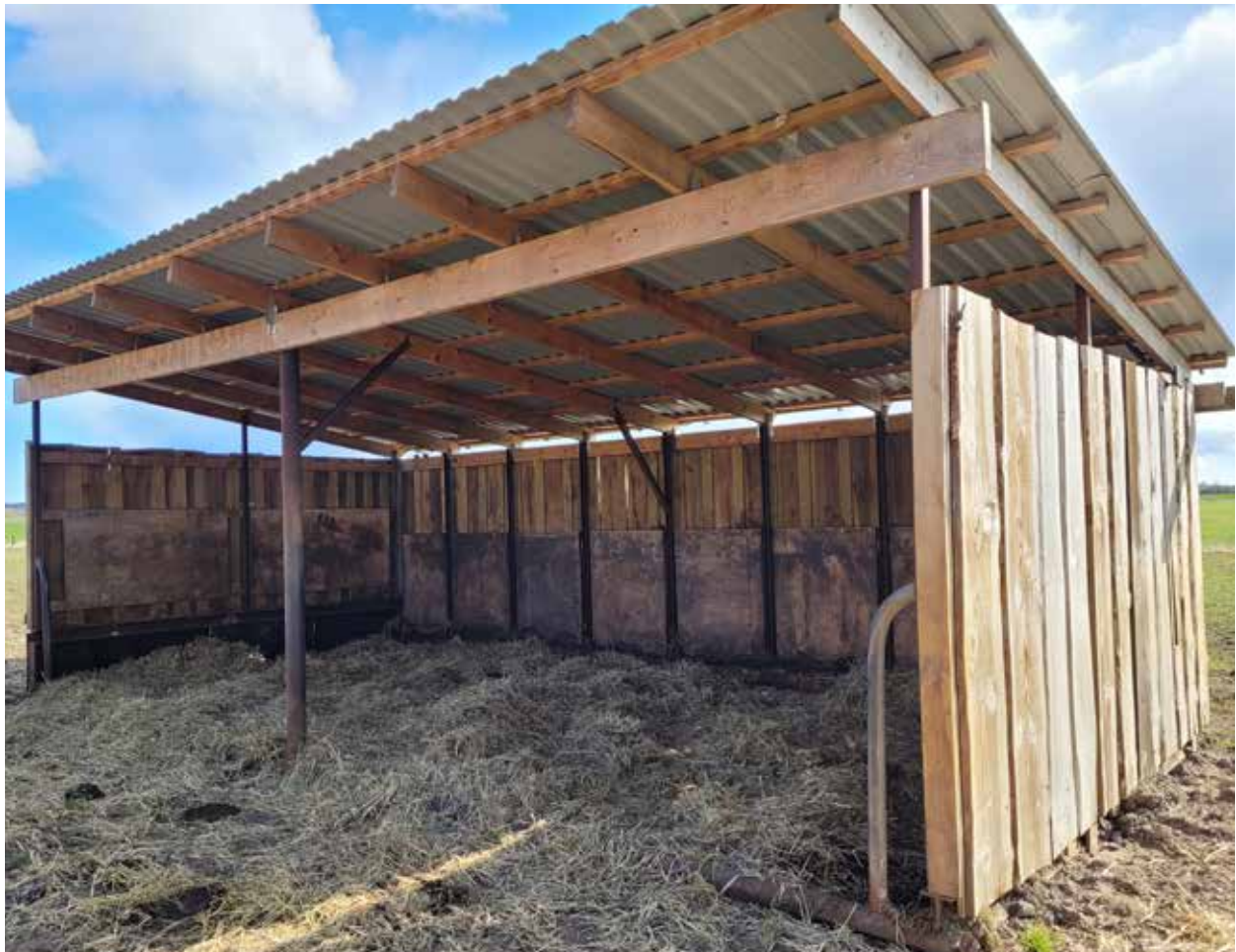
Billede 7. Læskur på stålramme giver mulighed for flytte det
