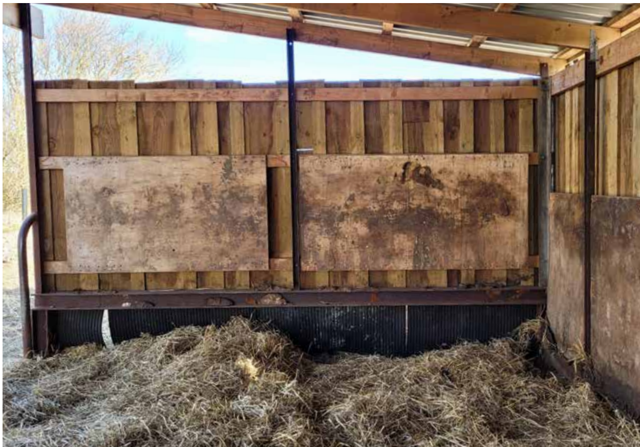
Billede 9. Der er sat plader indvendigt for at beskytte plankerne indvendigt i læskuret
