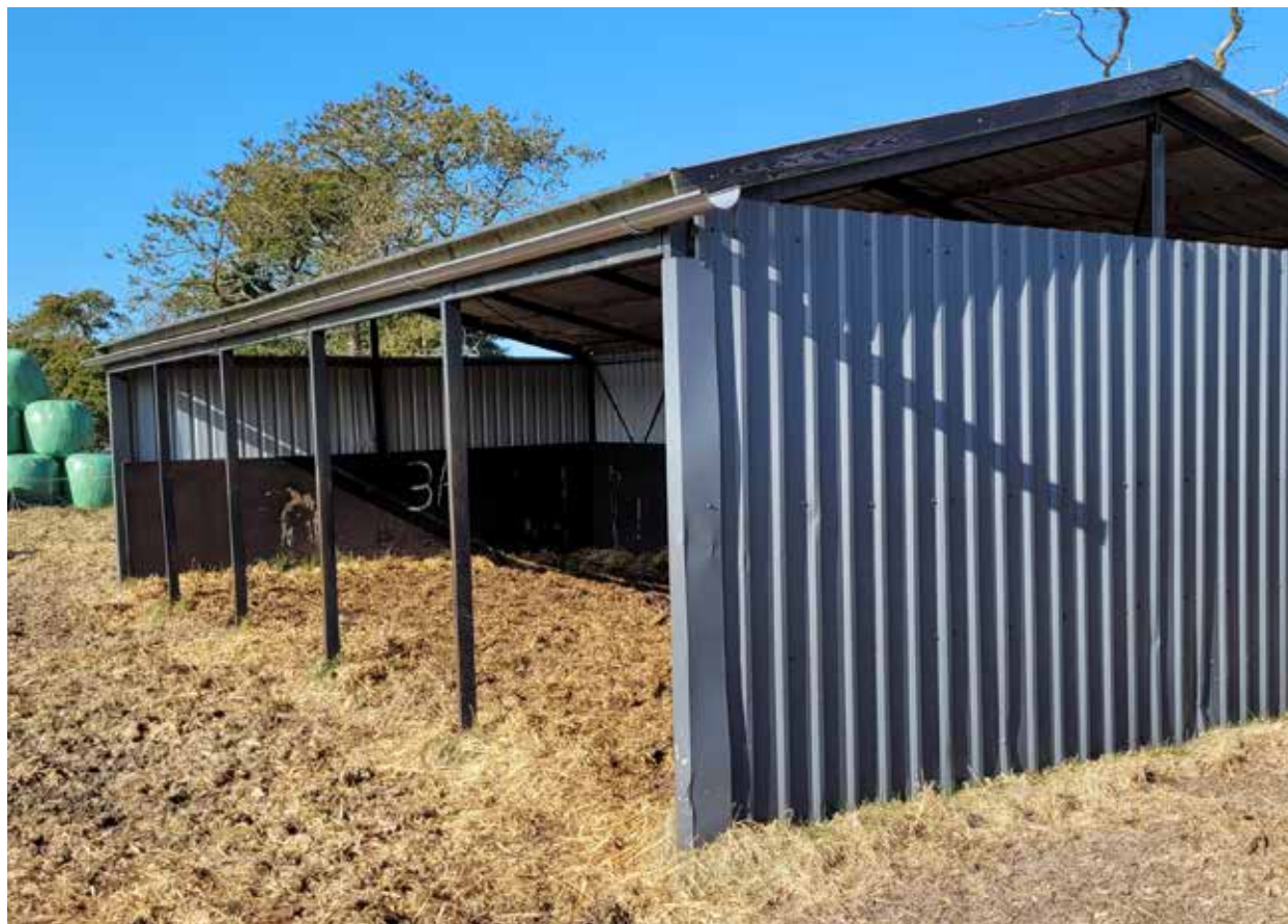
Billede 13. Læskur med åben langside med stålplader
