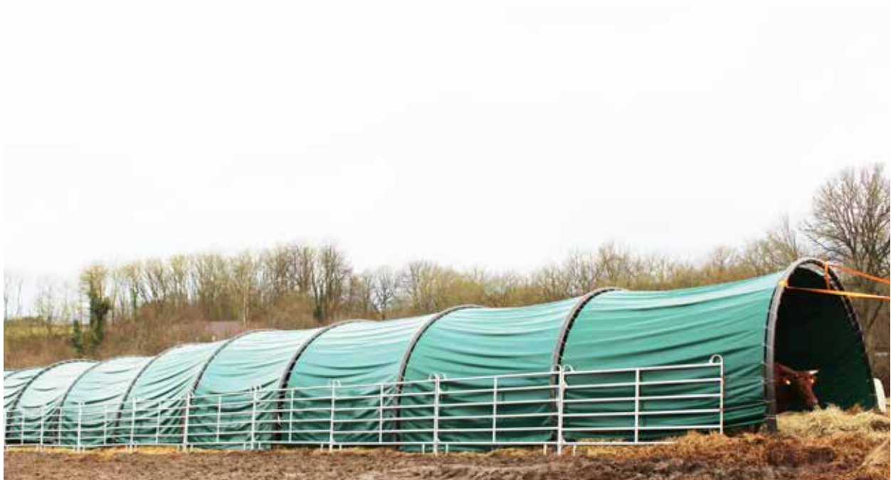
Billede 3. 10 fag er sat op til denne teltstald. Flytbare hegn forhindrer dyrene at gå under teltsiden
