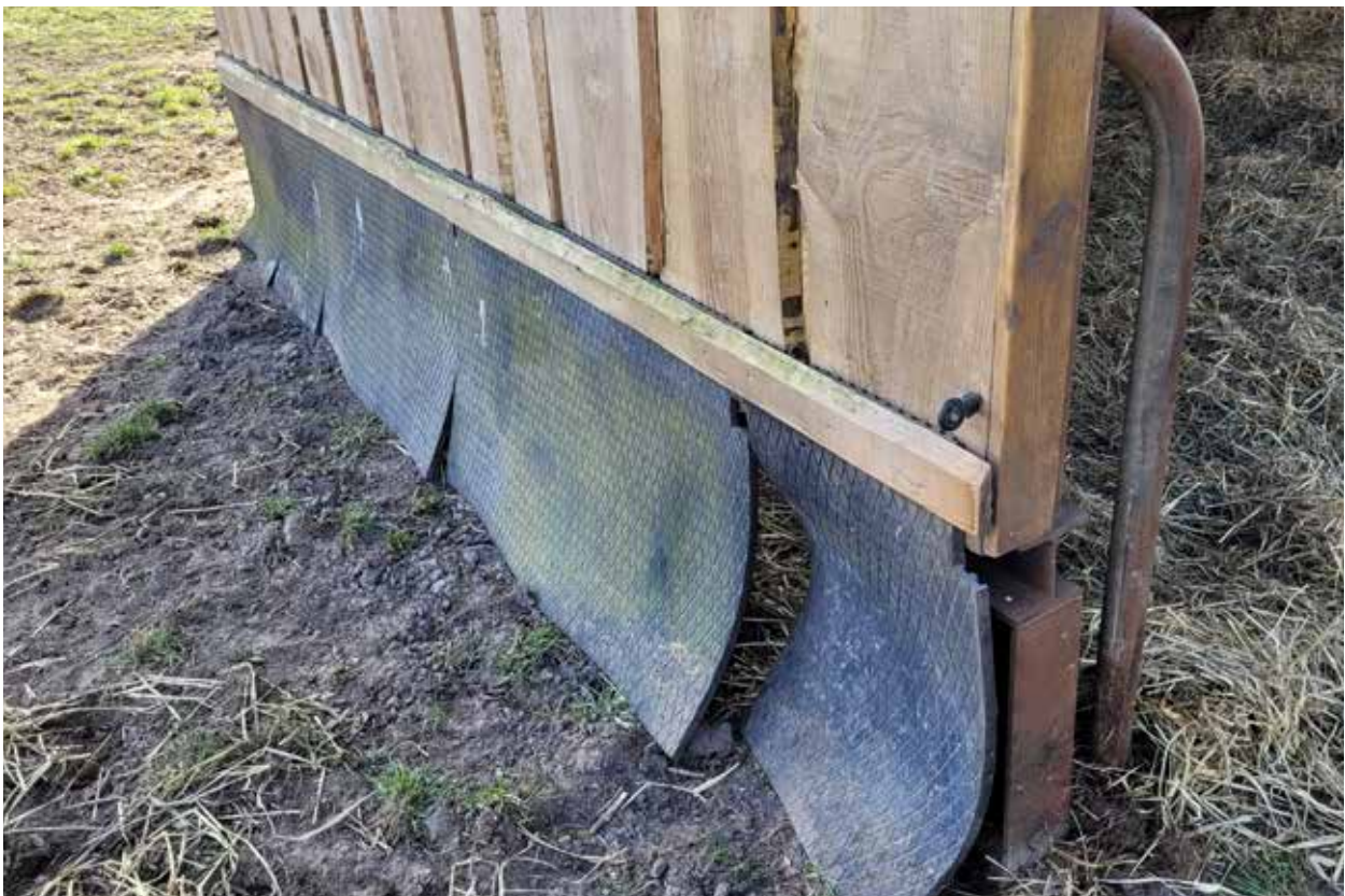
Billede 8. Gummimåtter minimerer træk og gør at dybstrøelsen ligger tilbage, når læskuret flyttes
